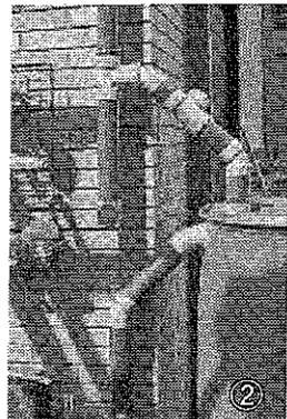
加工して雨水をタンクに導く。途中にゴミ除けの金網を設置。雨どいの切断部分から下に残した30センチ部分は土砂だまりとし、下部に栓をつけたまった土砂を取り除く。タンク上部に着けたオーバーフローした雨水を導くパイプは、切断した本来の雨どいの残り部分に接続する。写真②。
