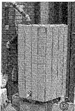
このままでもOKだが、見覚えを考え木の囲いをつける。タンクの容積は220リットルで屋根面積にもよるが、1度雨が降ればほぼ満杯に。植木の水やりや車の洗車に十分使える量だ。写真③。
